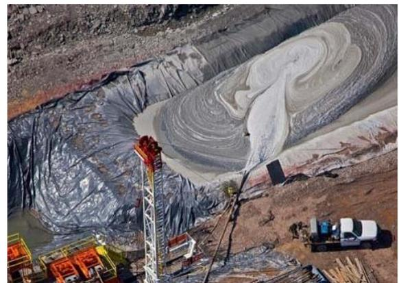
Figura 2. Embalses superficiales donde se almacenan a cielo abierto los lodos residuales del proceso de fracking, representan peligro para el ambiente y la salud de los trabajadores por los elementos tóxicos que contienen.
