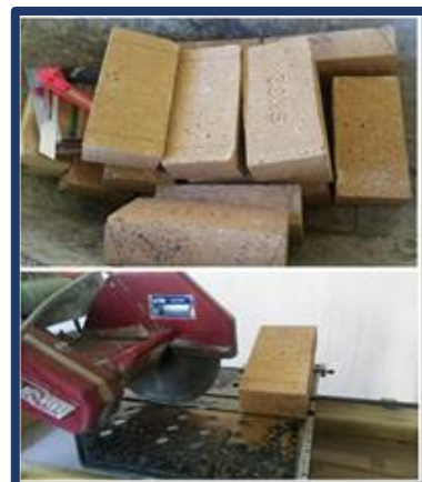
Fig. A.6 Ladrillos marcados y cortados.
