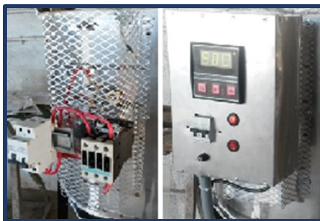
Fig. A.18 Colocación de ventilación, gabinete de control y conexión del sistema eléctrico.
