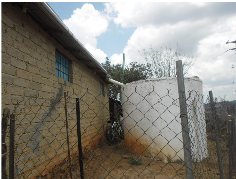
Fig. 3. 5 Cisterna para captar el agua de la lluvia
